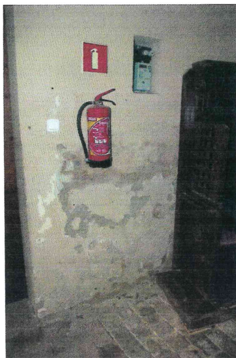
Fot. 5. Miejscowe porażenie biologiczne grzybem pleśniowym, zawilgocenie i krystalizacja soli
